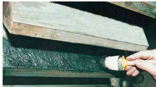
Der Schmierfilm muss gleichmäßig und ohne Luftpneinschluss aufgetragen werden. The film of lubricant must be applied evenly and without air-bubbles.
