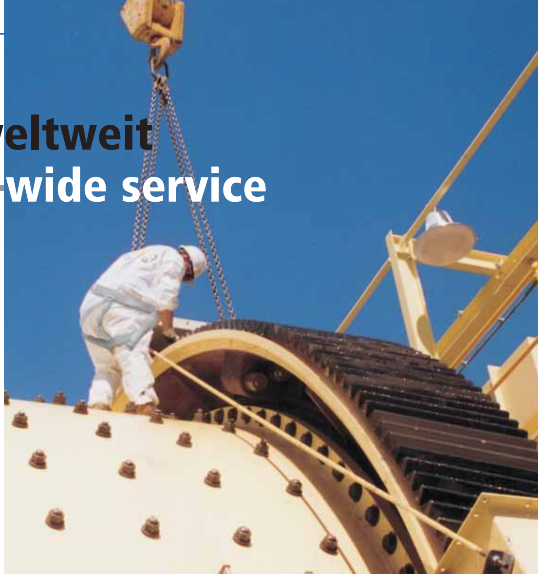
Inspektionen und Reparaturen vor Ort zählen zum Service von FUCHS LUBRITECH. Inspections and repairs on site are part of the FUCHS LUBRITECH service.
